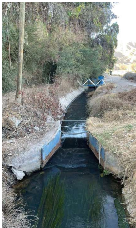
Figura 7. Canalización del río Copiapó en la región de Atacama. Fotografía tomada por el equipo de SMI durante una visita a terreno.
